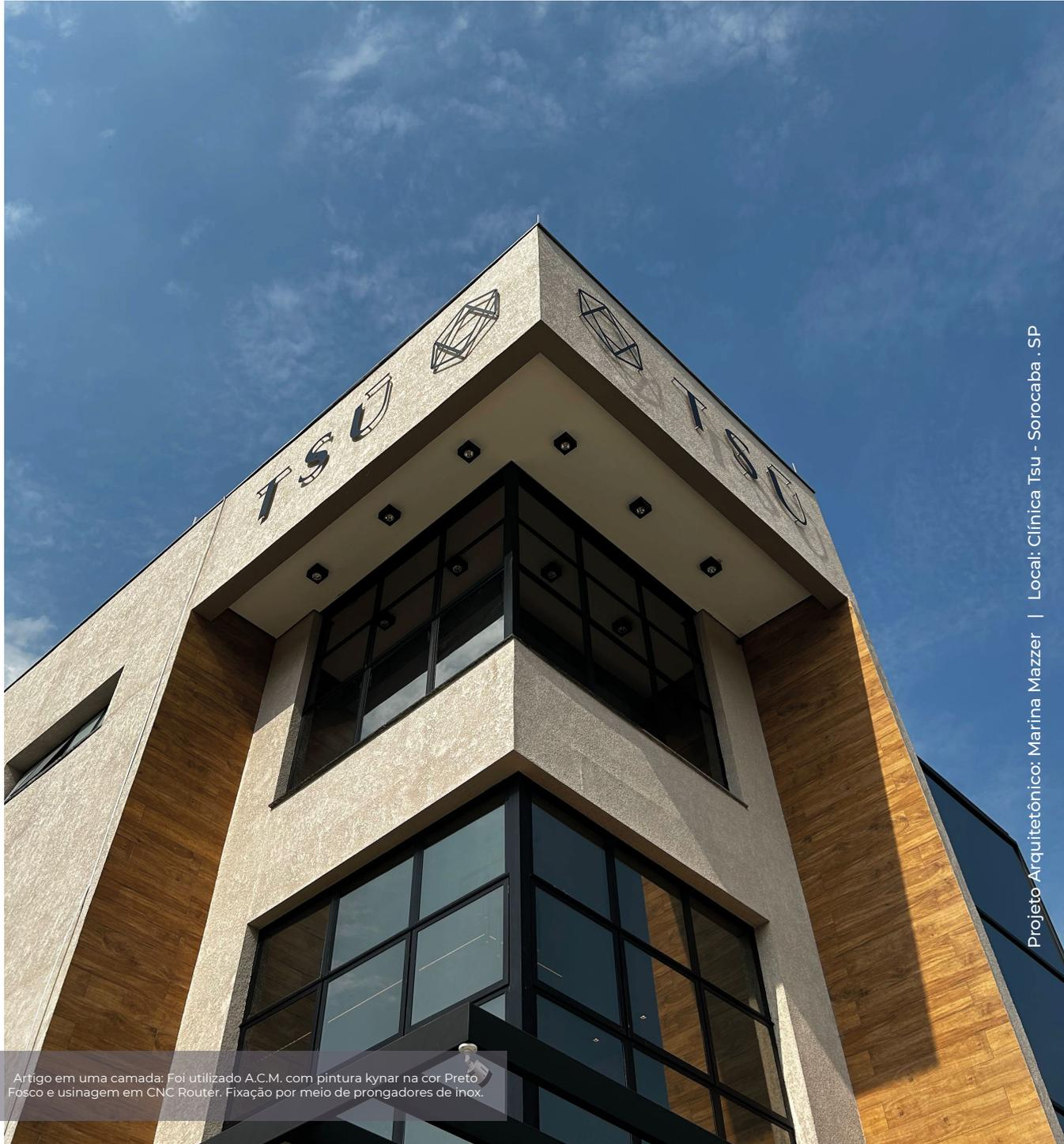
Artigo em uma camada: Foi utilizado A.C.M. com pintura kynar na cor Preto Fosco e usinagem em CNC Router. Fixação por meio de prongadores de Inox.
