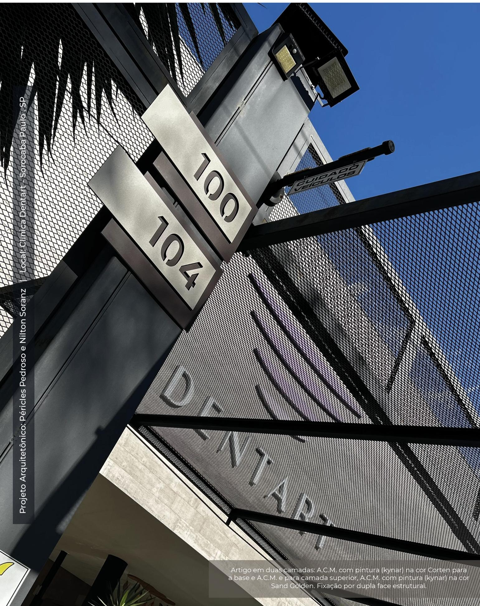
Artigo em duas camadas: A.C.M. com pintura (kynar) na cor Corten para a base e A.C.M. e para camada superior, A.C.M. com pintura (kynar) na cor Sand Golden. Fixação por dupla face estrutural.
